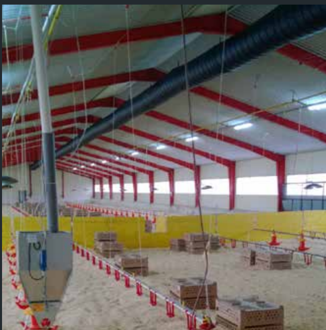
Warmluftverteilung durch Warmluftschlauch.
