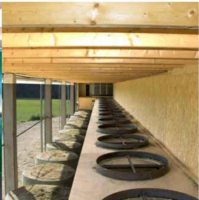
Seitlich am Gebäude errichtete Blechkanaltrocknung mit Luftentfeuchter und automatischem Vorhang.
