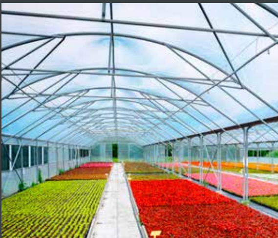
Glashausheizungen für Gemüse- und Blumenaufzucht werden mit LaTherm-Geräten betrieben.
